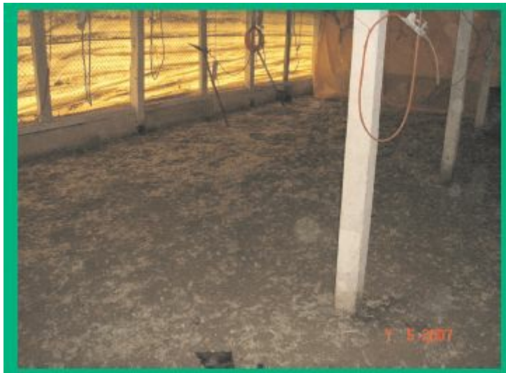
Figura 18 - Aviário de frango de corte com limpeza inadequada para alojamento de um lote novo.
