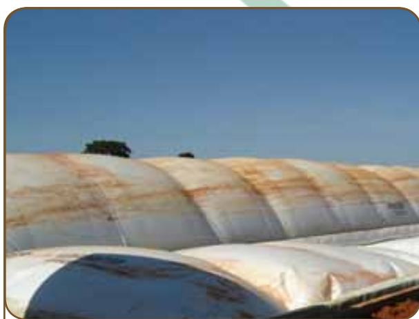
Figura 7: Biodigestor em lona de PVC.
