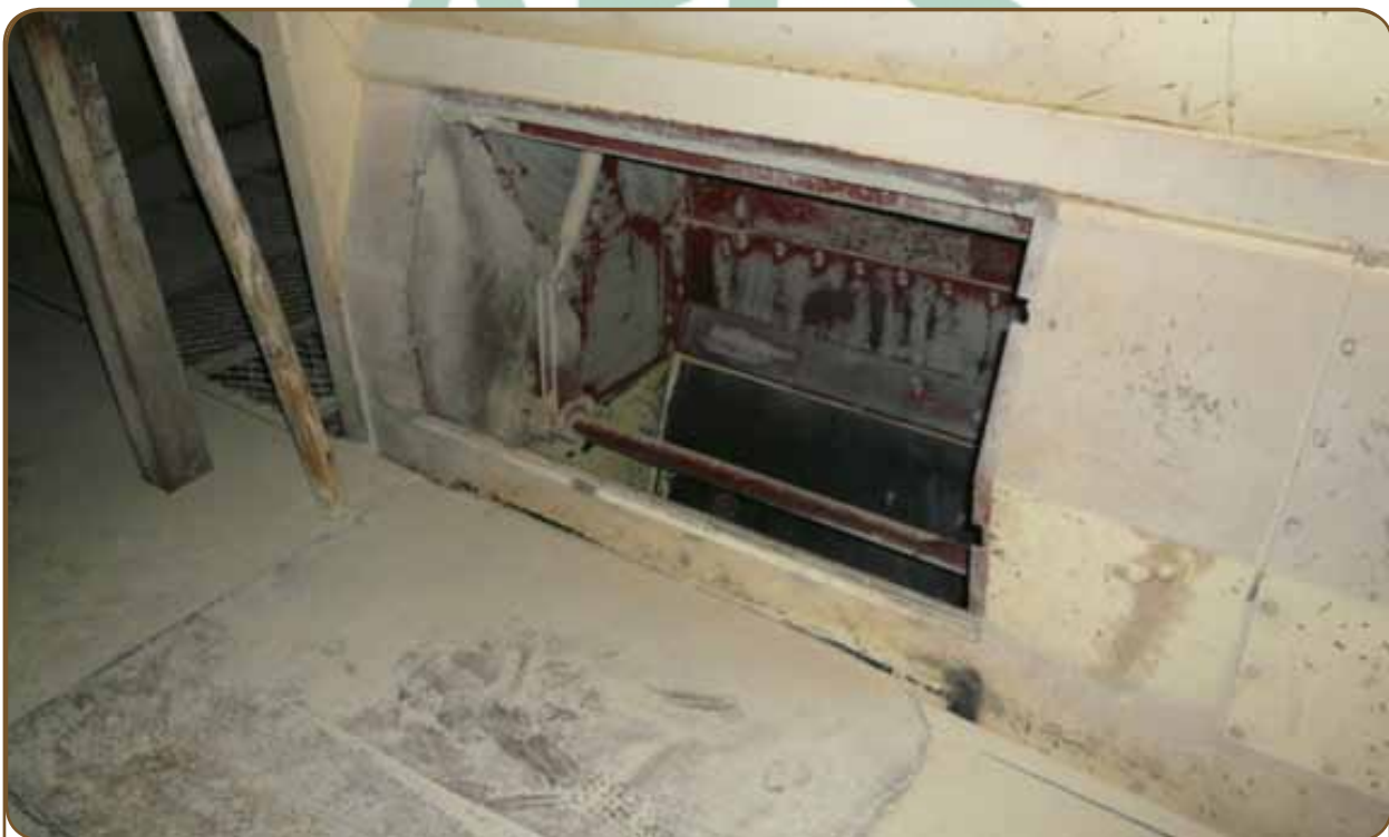
Figura 27: Abertura no misturador para realização de limpeza.
