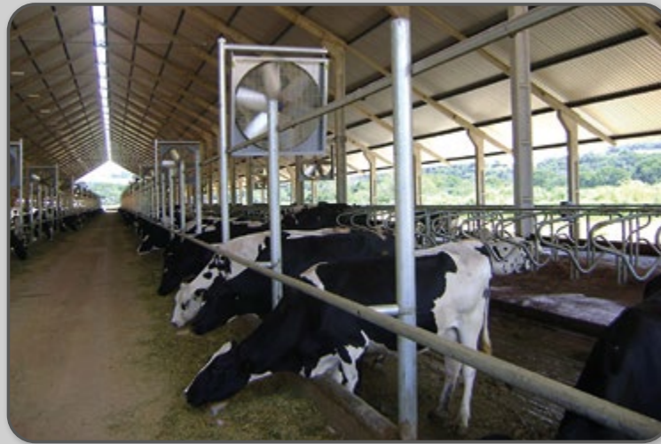
Figura 38 – Ventilação nos cochos, com aspersão.
