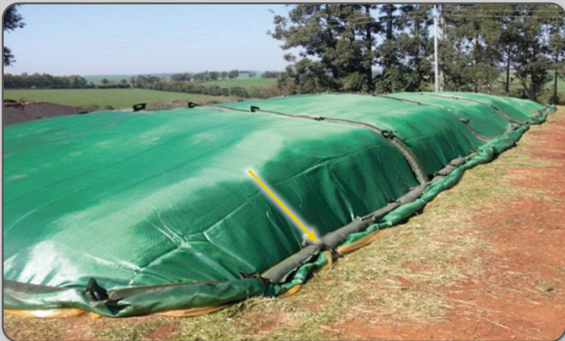
Figura 33 – Vista de um silo superfície com detalhes da vedação no entorno da pilha.
