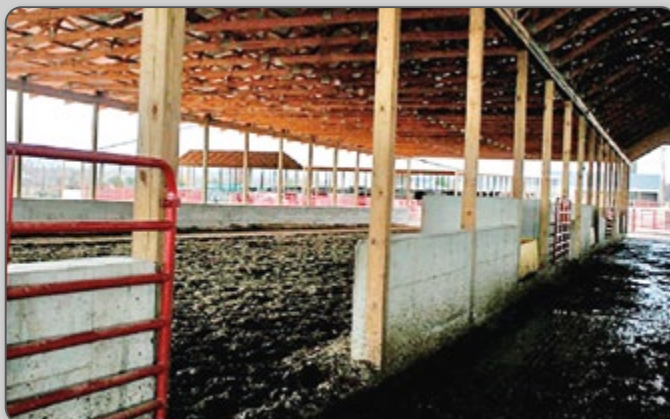
Figura 50 – Muretas de concreto com entradas a cada 15 m.
