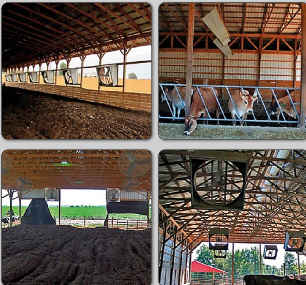
Figura 52 – Ventilação artificial em sistema Compost Barn .
