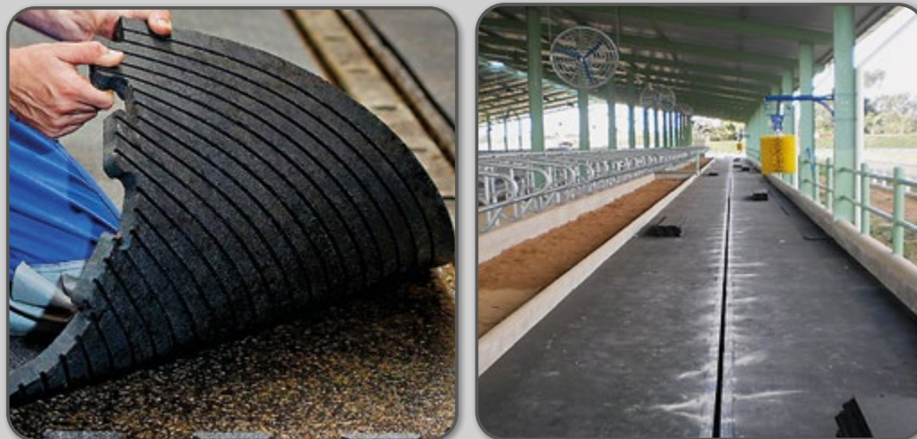
Figura 39 – Piso de borracha em galpão free stall .
