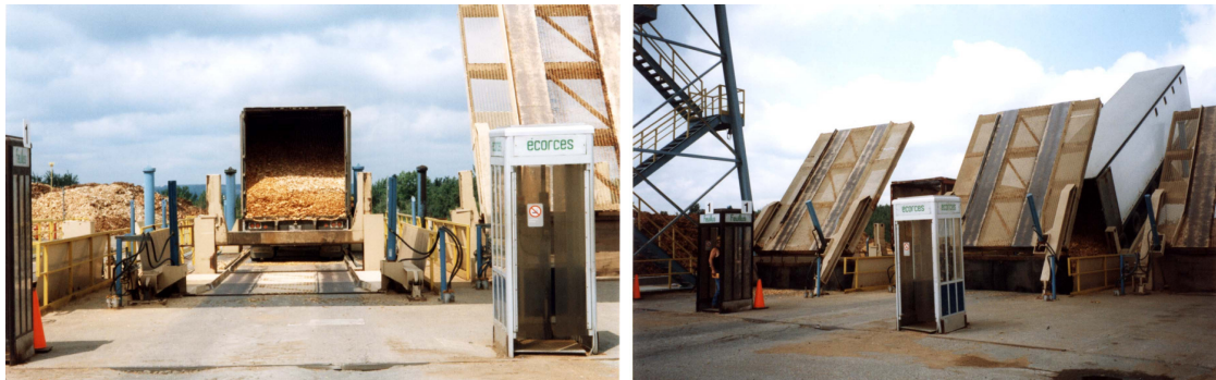
Figura 19. Contêiner de cavacos sobre plataforma (Esq.) e elevação da plataforma e descarregamento dos cavacos (Dir.).
