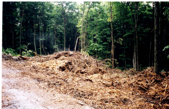
Figura 18. Material residual acumulado ao lado do carregador.
