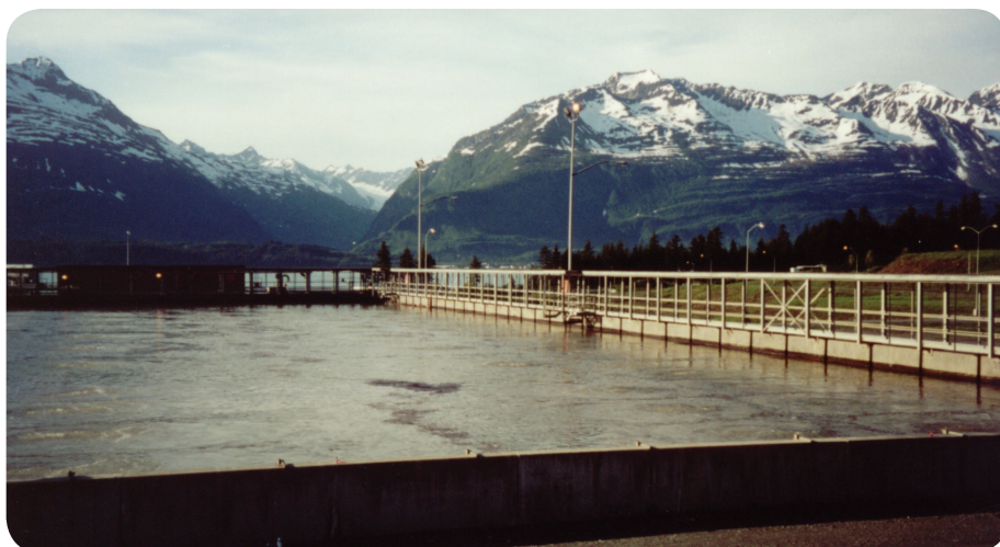
Figura 13.2. Tanque de biorremediação de água contaminada com petróleo que chega dos navios, no porto de Valdez, Alasca. Após o tratamento a água de lastro é lançada ao mar. FONTE: Foto de Alexandre Verzani Nogueira – (arquivo pessoal - Alasca, EUA, junho de 2001).
