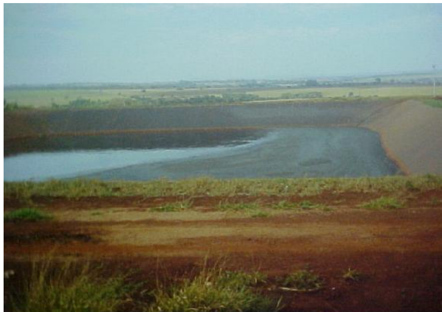
Figura 17 – sistema tradicional de manejo de dejetos utilizando lagoas de estabilização.
