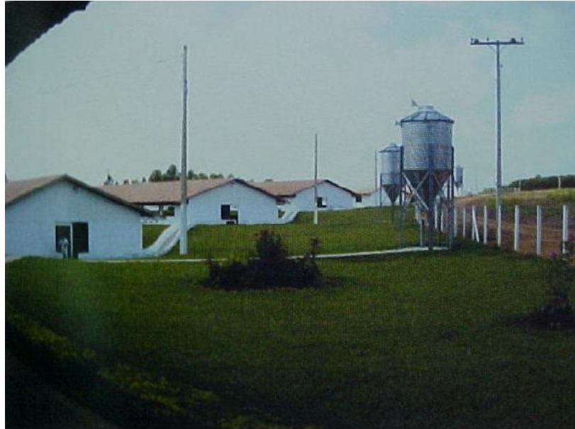
Figura 3 – cercas de proteção utilizadas para delimitarem áreas.
